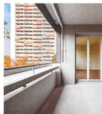
Titelbild: Die Fambau schuf im Tscharnergut-Hochhaus Waldmannstrasse 25 mehr Balkon- und Wohnfläche.
