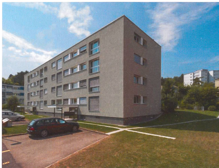
Gesamtsanierung MFH Am Brunnenbächli in Zollikerberg
