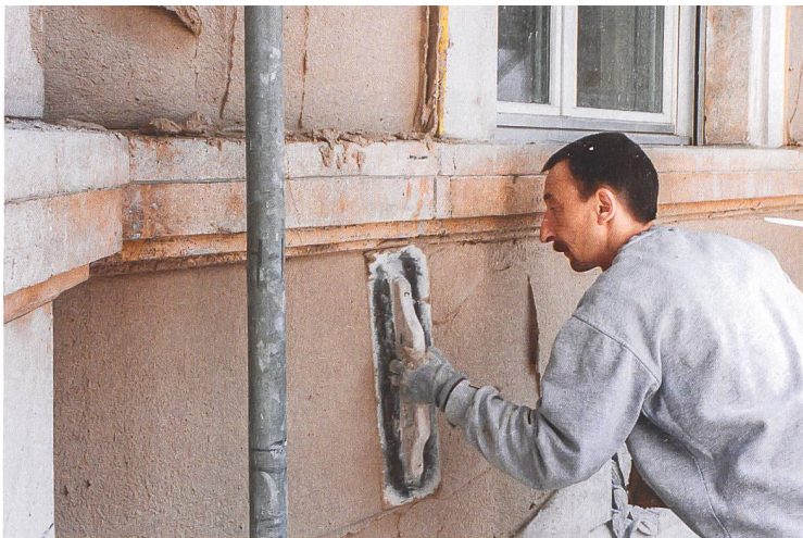
Aufbringen des Aerogel-Putzes.
