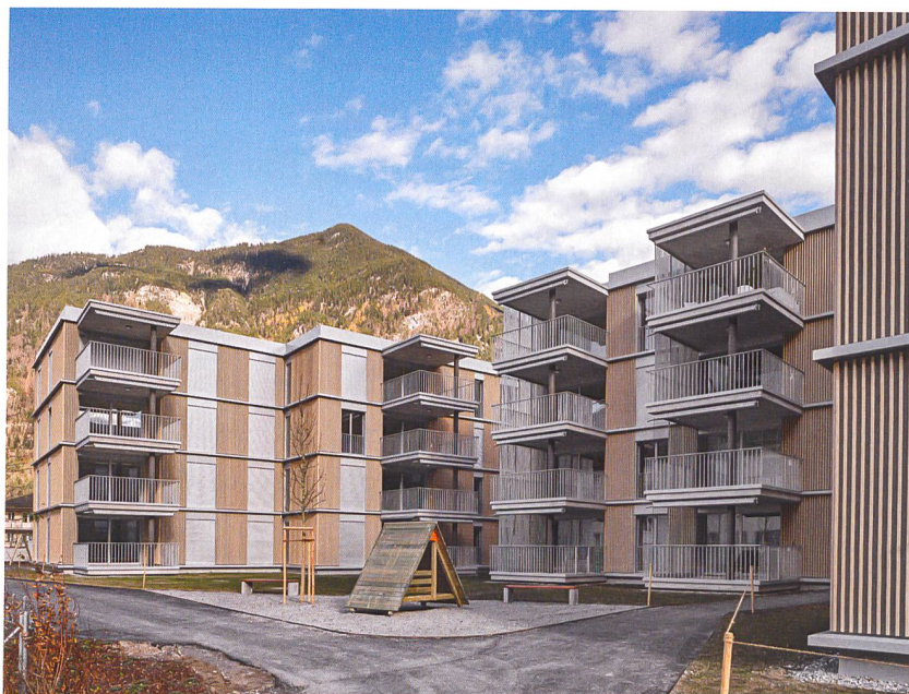
Von unten bis oben gleich: Die rationelle Bauweise wirkt positiv auf die Kosten.
