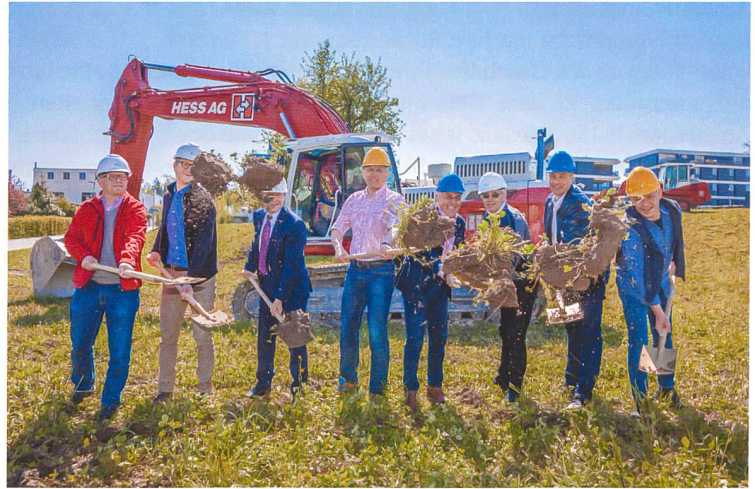
Vor rund 40 Gästen griffen Vertreter von BGZ, Gemeinde und Projektbeteiligten zum Spaten.
