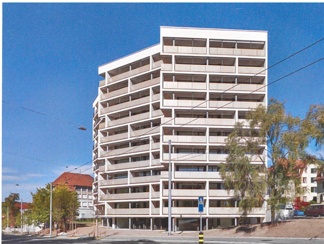
Das SAW-Hochhaus Scheuchzerstrasse wurde auf der Süd- und der Westseite durch eine vorgelagerte Gebäudeschicht mit Balkonen erweitert.
