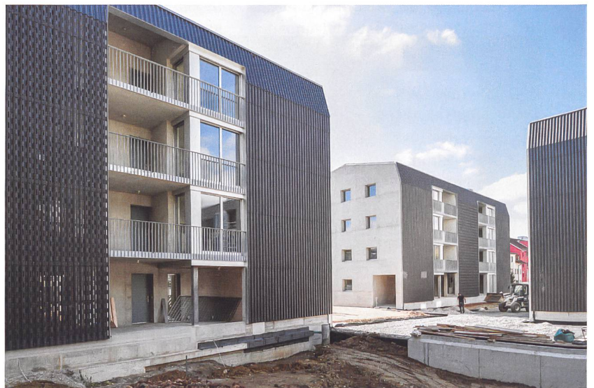
Die Erschliessung der Wohnungen erfolgt über Laubengänge.
