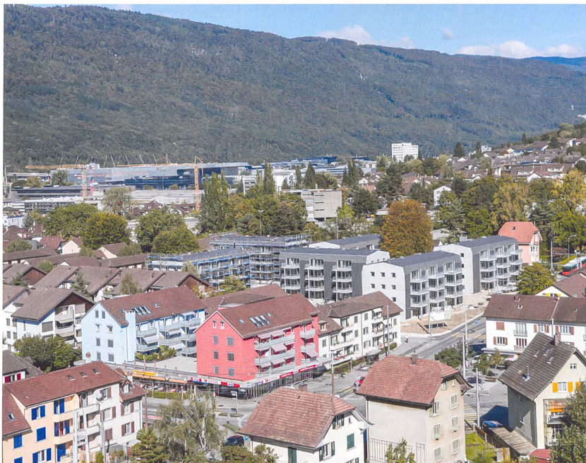
Der Wohnpark Les Amis liegt im Bieler Quartier Mett. Die sechs Häuser der ersten Etappe sind weitgehend fertiggestellt, bei der zweiten Etappe (links von den Neubauten) wird es 2018 soweit sein.
