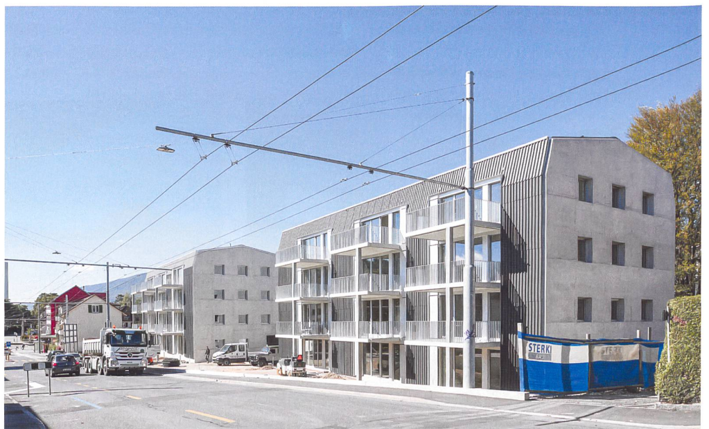
Die Neubauten vom Geyisriedweg aus gesehen.
