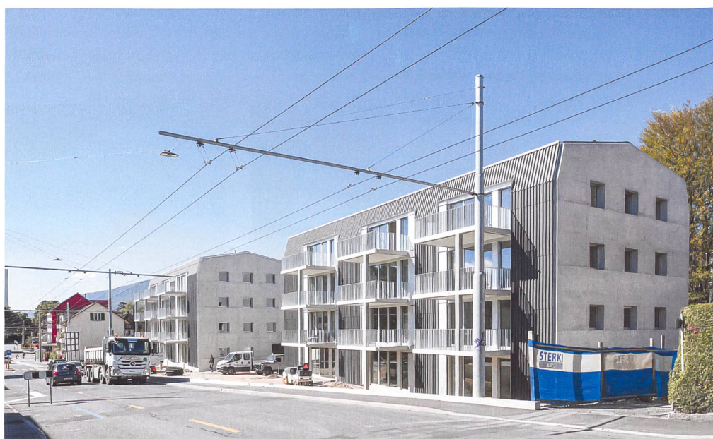
Die Neubauten vom Geyisriedweg aus gesehen.
