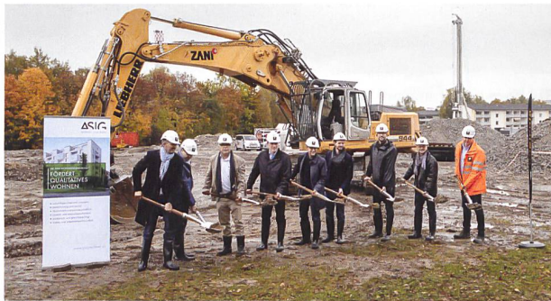
Rund 230 Wohnungen erstellt die ASIG in Zürich Schwamendingen.
