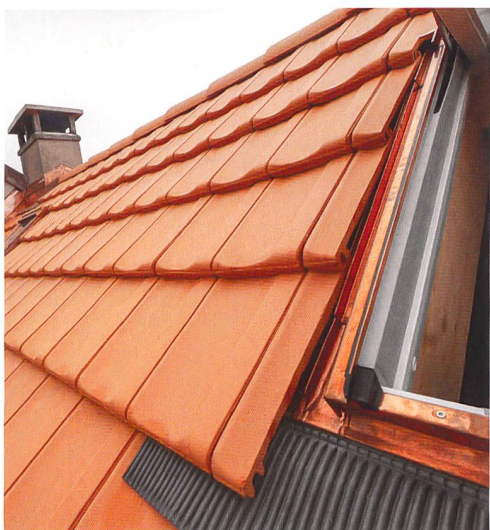
Blick auf ein erneuertes Dach.
