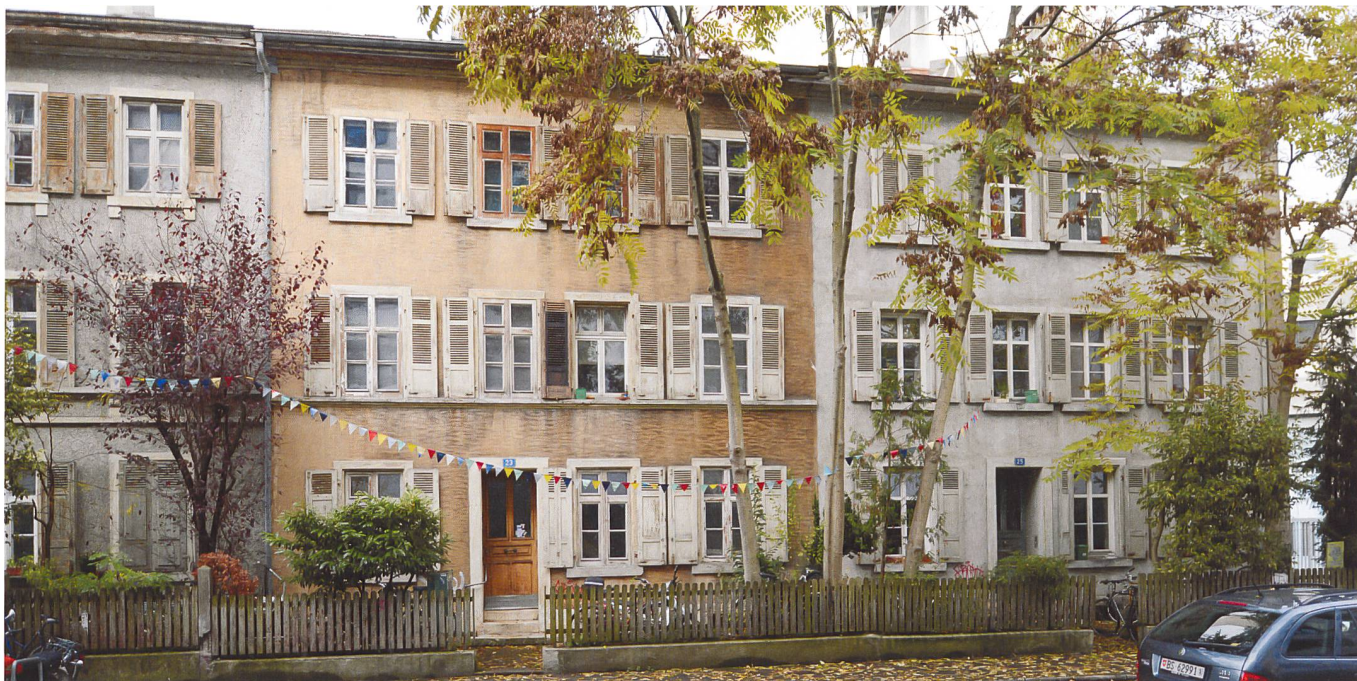
Weitere Renovationsetappen werden in den nächsten Jahren folgen. Ob die Originalholzfenster nur ausgebessert oder doch ersetzt werden, wird basisdemokratisch entschieden.
