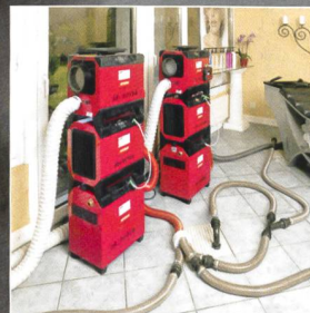
Wasserschadentrocknung
