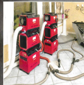
Wasserschadentrocknung
