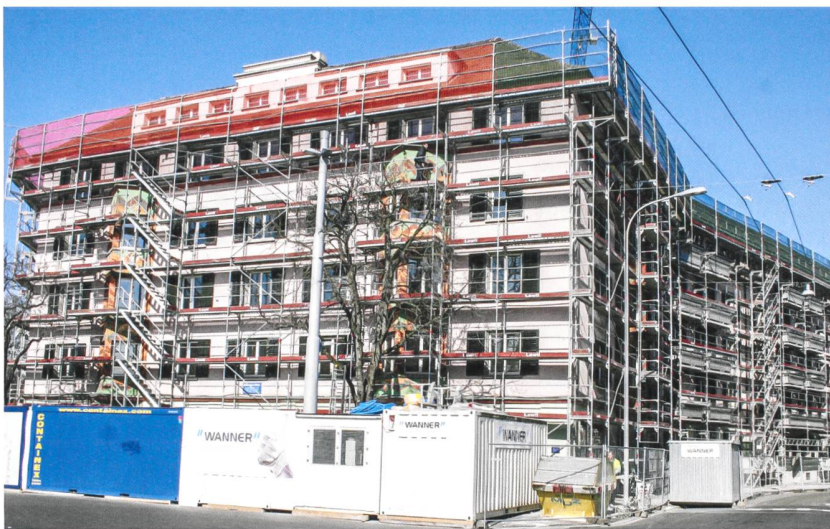
Die ABZ setzt bei der Finanzierung auf einen Mix verschiedener Hypotheken und Laufzeiten. Im Bild die Siedlung Sihlfeld, anlässlich der umfassenden Sanierung im Jahr 2012.
