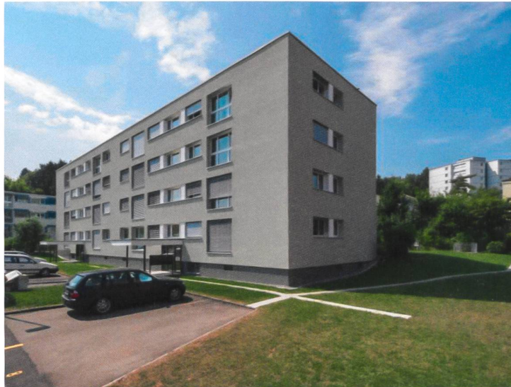
Gesamtsanierung MFH Am Brunnenbächli in Zollikerberg
