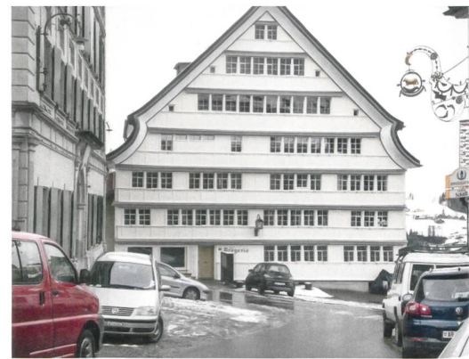
Frisch sanierte Fassade ...
