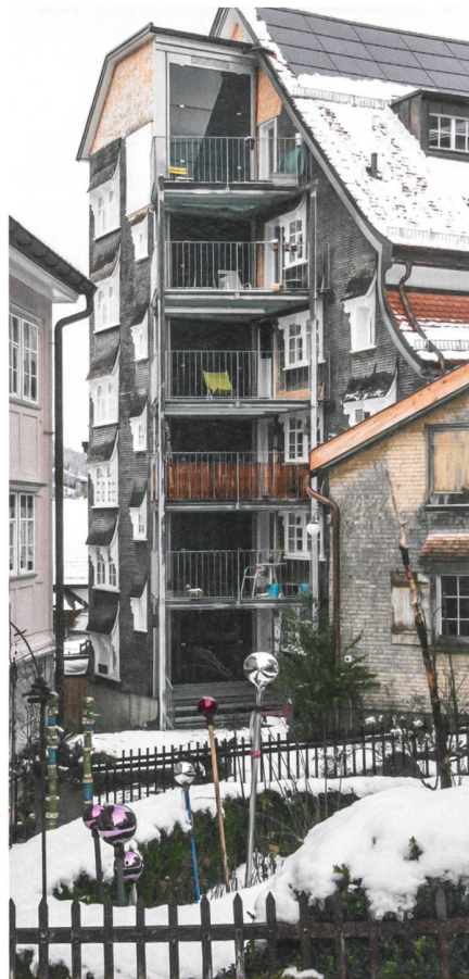
Lift und neue Balkone auf der Rückseite.
