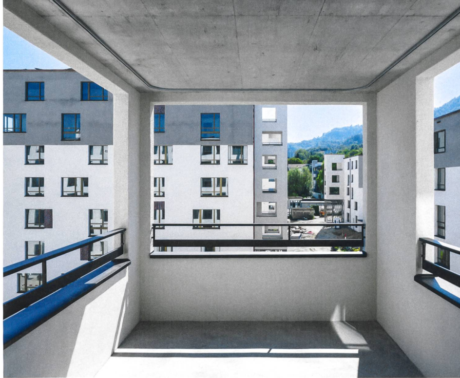
Alle Wohnungen wurden nach aussen geöffnet, entweder über grosse «Freiluftzimmer» in den Balkontürmen oder über Gartensitzplätze.
