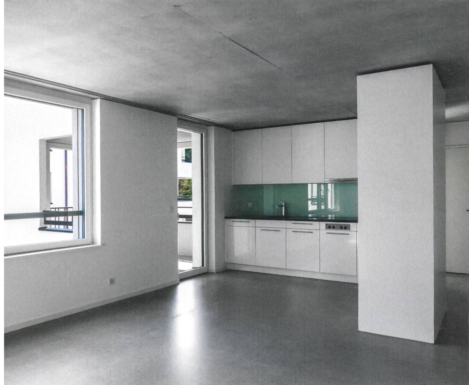
Offene Küche in einem der Langhäuser. Die dortigen urbanen Wohnungstypen verfügen über Anhydritböden, bei den konventionelleren Hofhäusern wählte man Parkett.
