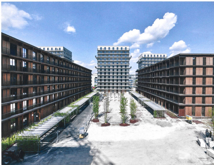
Die drei langen Wohnriegel aus Holz bilden einen Kontrast zu den benachbarten Betontürmen.
