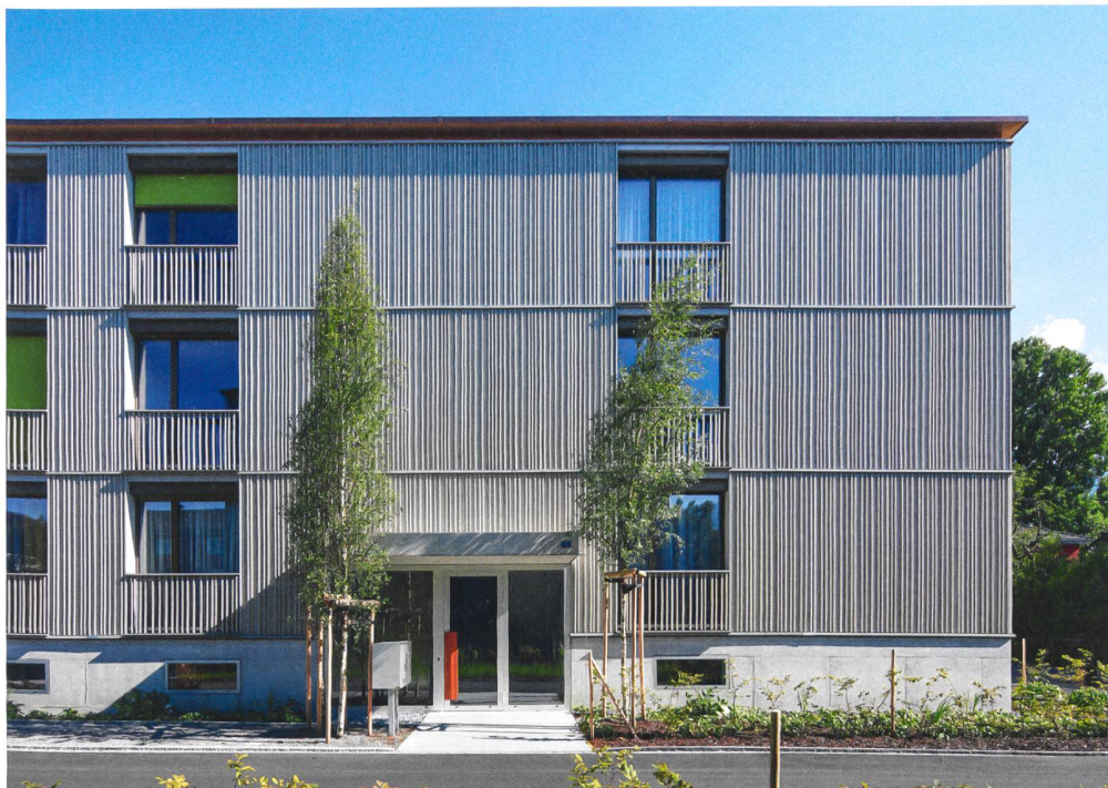
Blick auf den Eingangsbereich. Unregelmässige Abstände der vertikalen Holzelemente beleben den Gesamteindruck.
