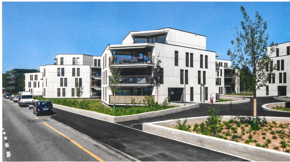
Trotz ähnlicher Bautypologie entsteht durch die unterschiedliche Platzierung der einzelnen Gebäude eine überraschende optische Vielfalt.
