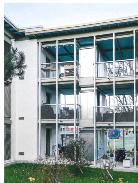
Die grossen Loggien bilden ein zusätzliches «Ausenzimmer».
