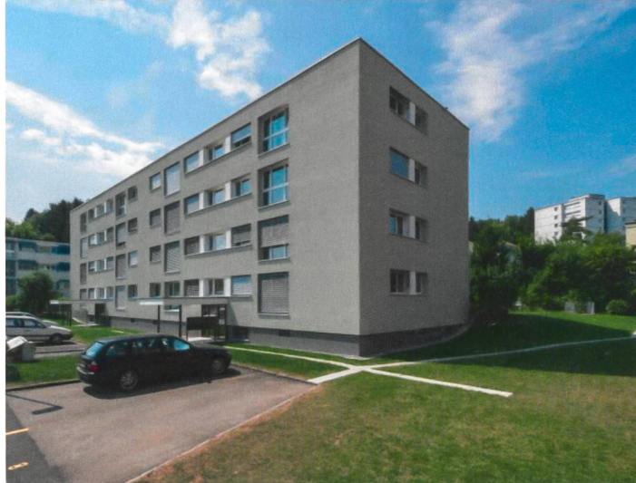
Gesamtsanierung MFH Am Brunnenbächli in Zollikerberg
