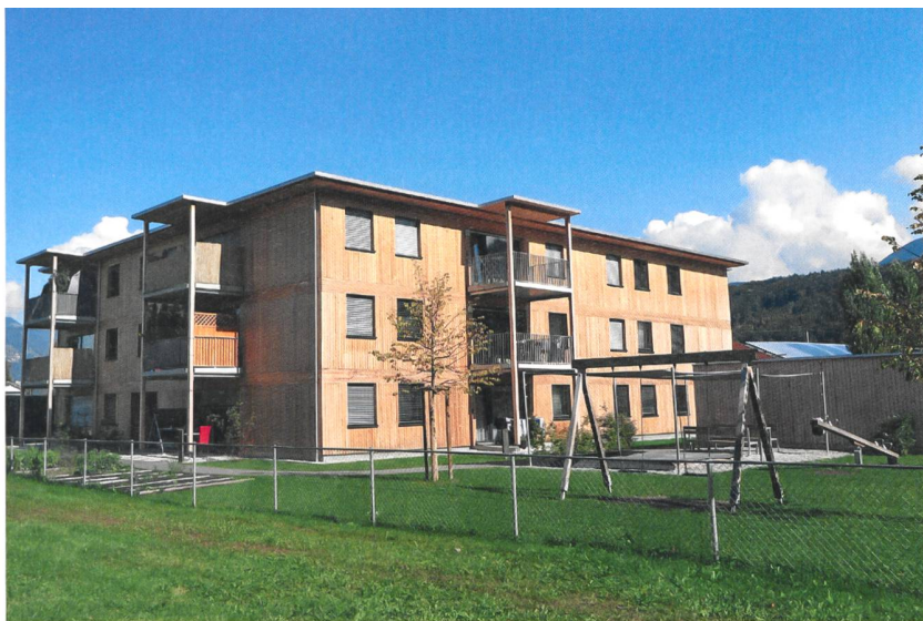
In Feldkirch Altenstadt erstellte die Wohnbauselbsthilfe vorgefertigte Bauten in Holztafelbauweise.
