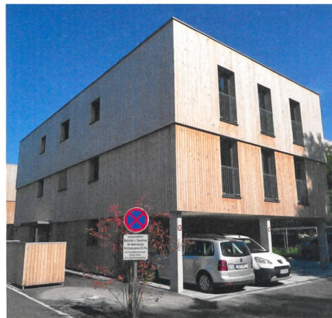
Bei den Häusern in Rankweil kam die Holz-Beton-Verbundbauweise zum Einsatz.
