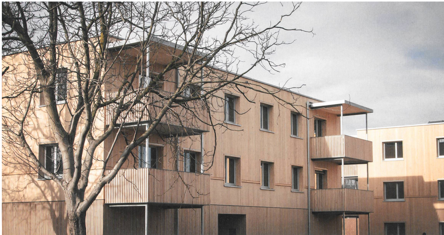
Jede Wohnung besteht aus drei vorgefertigten Modulen. Die gesamte Bauzeit dauerte nur drei Monate.
