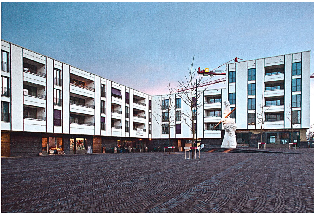
Verströmt «Piazza»-Flair: der mit dunklen Klinkersteinen versehene neue Friesenbergplatz.
