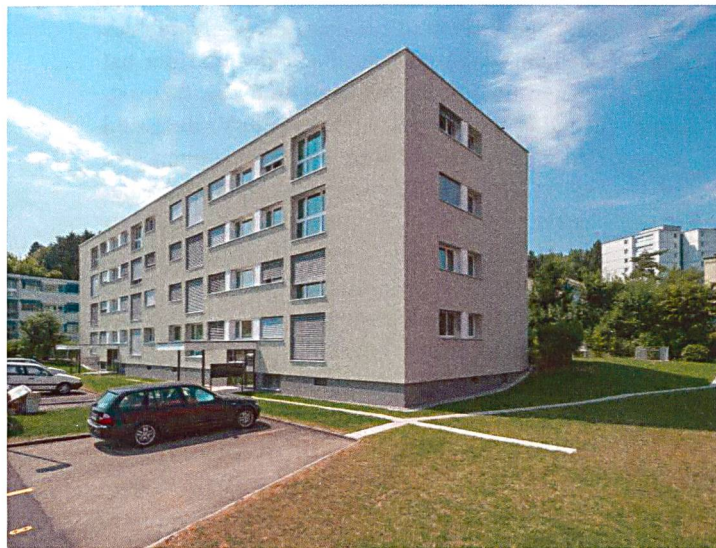
Gesamtsanierung MFH Am Brunnenbächli in Zollikerberg
