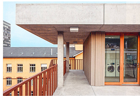
Im Attikageschoss befindet sich nicht nur eine Terrasse mit Grill, sondern auch der Waschraum.
