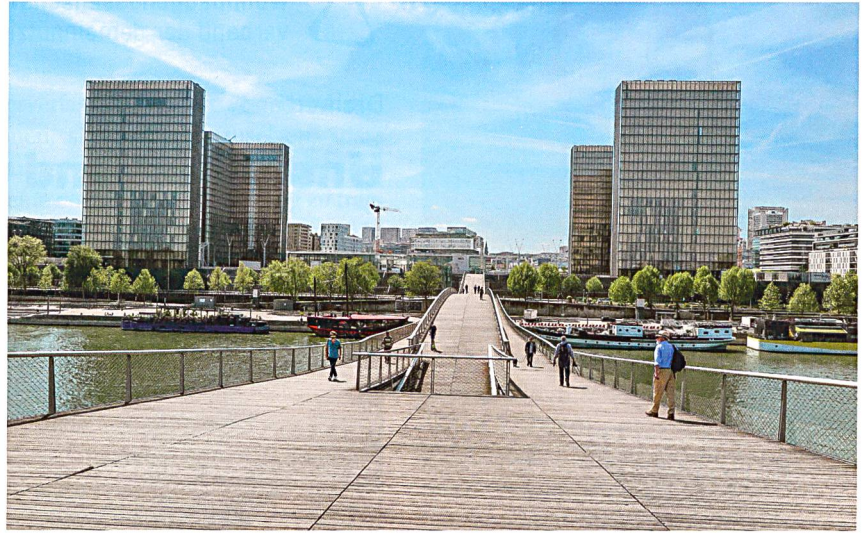
Der Langsamverkehr hat grosses Gewicht. Fussgängerbrücke vor der Bibliothèque nationale.
