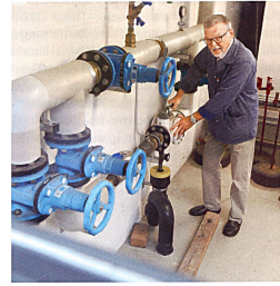
Die Wartung von Wasserinstallationen umfasst Anschlüsse und Leitungen ebenso wie die Kontrolle von Temperaturen und Drücken. Bild: Reparatur Hans Junker im Einsatz im Hochhaus Schwabgut der Eisenbahner-Baugenossenschaft Bern.
