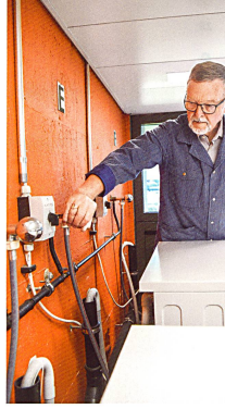
Die Wartung von Wasserinstallationen umfasst Anschlüsse und Leitungen ebenso wie die Kontrolle von Temperaturen und Drücken. Bild: Reparatur Hans Junker im Einsatz im Hochhaus Schwabgut der Eisenbahner-Baugenossenschaft Bern.
