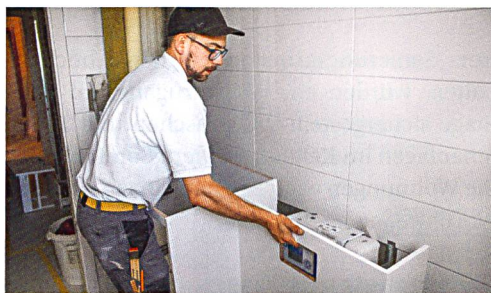
Vorwand und Möbel werden im Werk bereitgestellt, auf die Baustelle geliefert und dort montiert (im Uhrzeigersinn von links). Innert zehn Arbeitstagen können so 24 Bäder erneuert werden.
