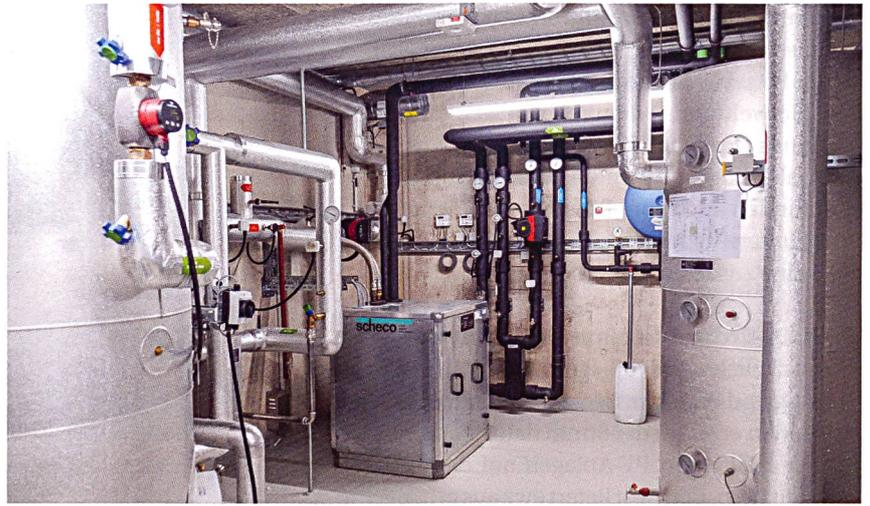
ewz-Projektleiter Pascal Leumann erklärt die verschiedenen Anlagen. Auf dem Bild links sind die schwarzen Erdsondenanschlussleitungen zu sehen, oben Warmwasserspeicher, Wärmepumpe und Pufferspeicher (von links).
