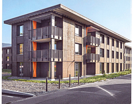
Um Verschmutzung und Alterserscheinungen vorzubeugen, sind die Fassadenplatten druckimprägniert und geölt.
