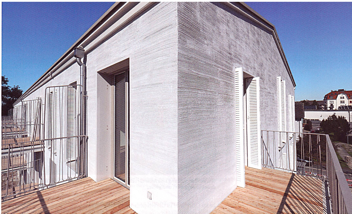
Die Wohnungen im Neubau Zwinglistrasse verfügen über grosse Aussenräume.
