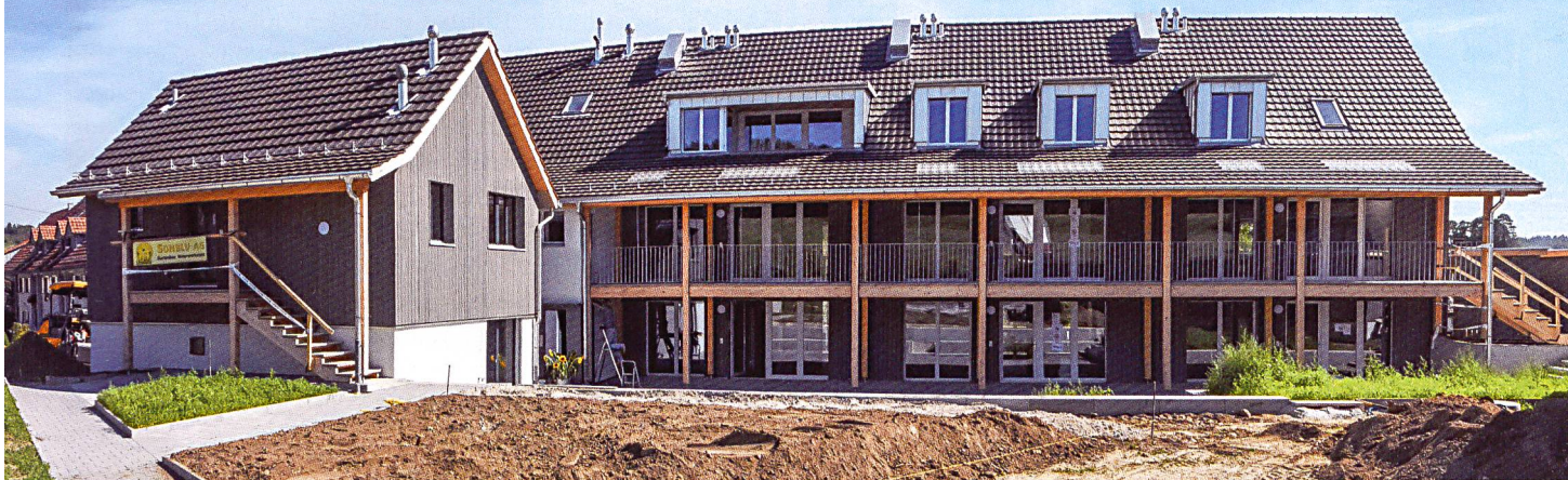
Das Ensemble besteht aus einem Langbau und einem Annexgebäude mit Gemeinschaftsraum und Dachwohnung.
