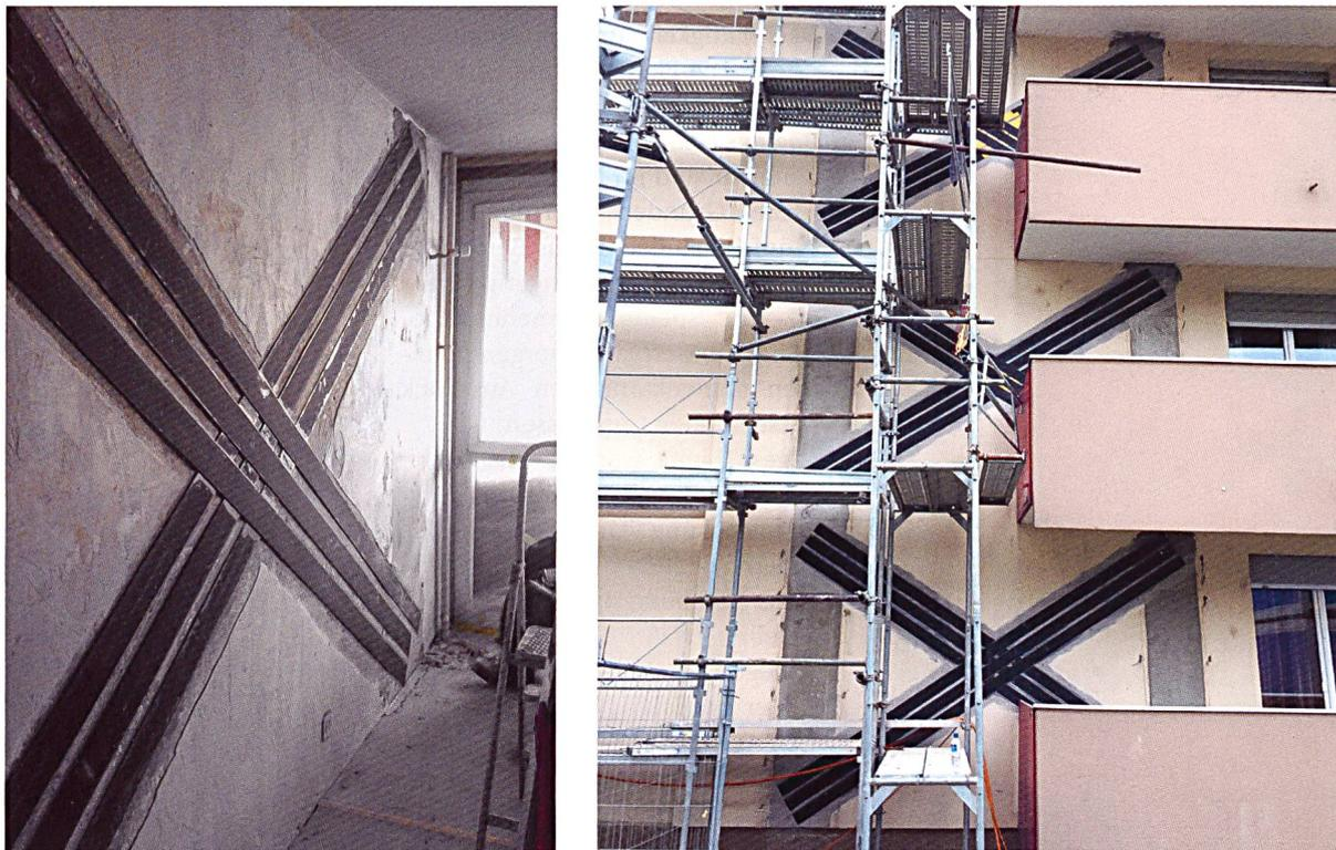
Kreuzweise eingesetzte Karbonstahllamellen sorgen für grössere Stabilität im Falle eines Erdbebens.
