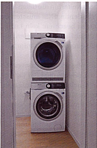
Alle Wohnungen verfügen neu über einen Waschturm.
