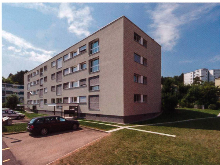
Gesamtsanierung MFH Am Brunnenbächli in Zollikerberg
