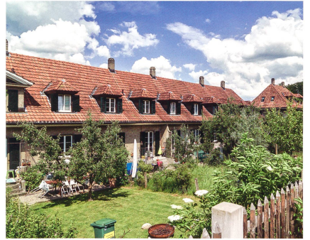
Die 212 Reiheneinfamilienhäuser unterscheiden sich sowohl in der Geschosshöhe als auch in den Details – und bilden doch eine Einheit.
