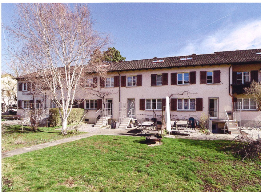
Früher waren die Gärten nur über den Keller zugänglich. Die neuen Aussentreppen sorgen nun für eine bequemere Nutzung.
