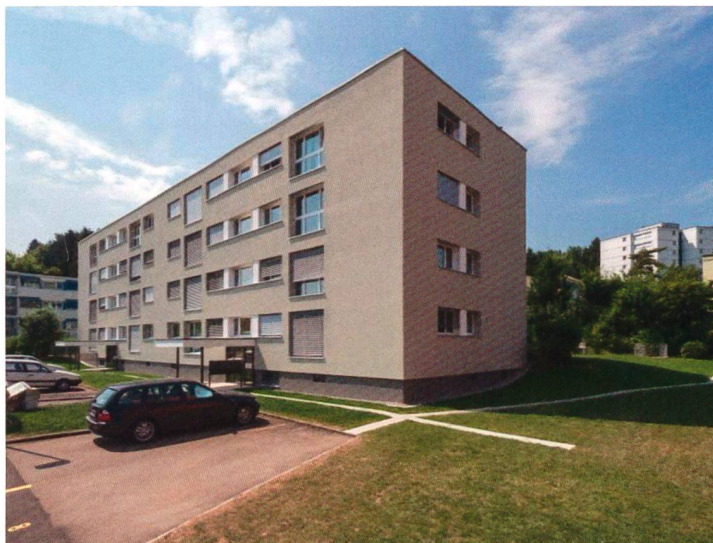
Gesamtsanierung MFH Am Brunnenbächli in Zollikerberg
