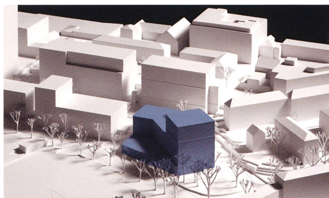
Brügger Architekten schlagen für das Baufeld U3 (Brünnen-Eichholz) einen Sockelbau vor, der sich in ein vier- und ein achtgeschossiges Volumen entwickelt.
