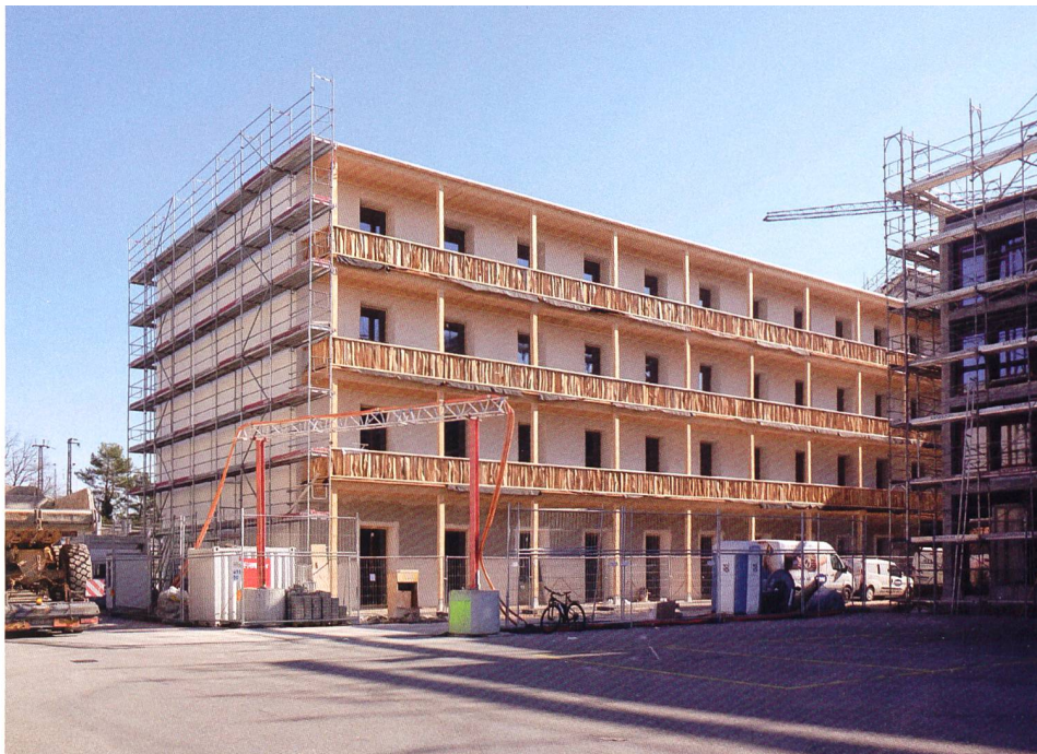
Blickfang des Neubaus ist die Balustrade, die der Künstler Andres Bally aus eigens gespaltenem Eichenholz hergestellt hat.
