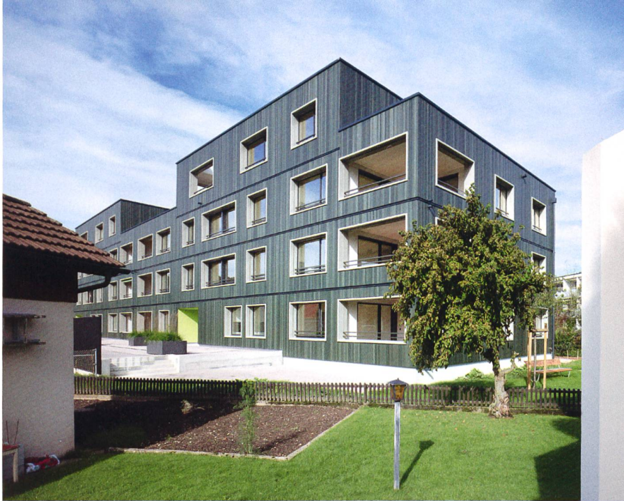
Swisswoodhouse ist ein von Bauart und Rengli AG konzipiertes Holzbausystem, das den Anforderungen an die 2000-Watt-Gesellschaft entspricht. Das erste Swisswoodhouse entstand in Nebikon (LU). Das gesamte Gebäude wurde im Werk vorgefertigt und vor Ort in nur drei Wochen montiert.
