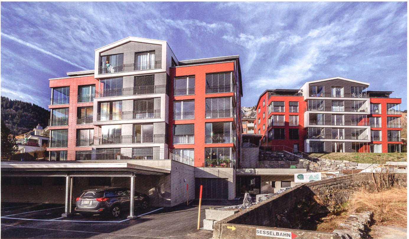
Der jüngste Neubau der Genossenschaft Alterswohnungen Linth stammt von 2017. Auf der Sonnenterrasse in Amden erstellte sie zwei Häuser mit 26 altersgerechten Wohnungen.
