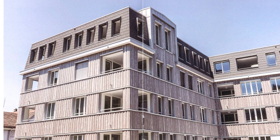
Die Fassadenverkleidung besteht aus vorvergrauter Weisstanne.
