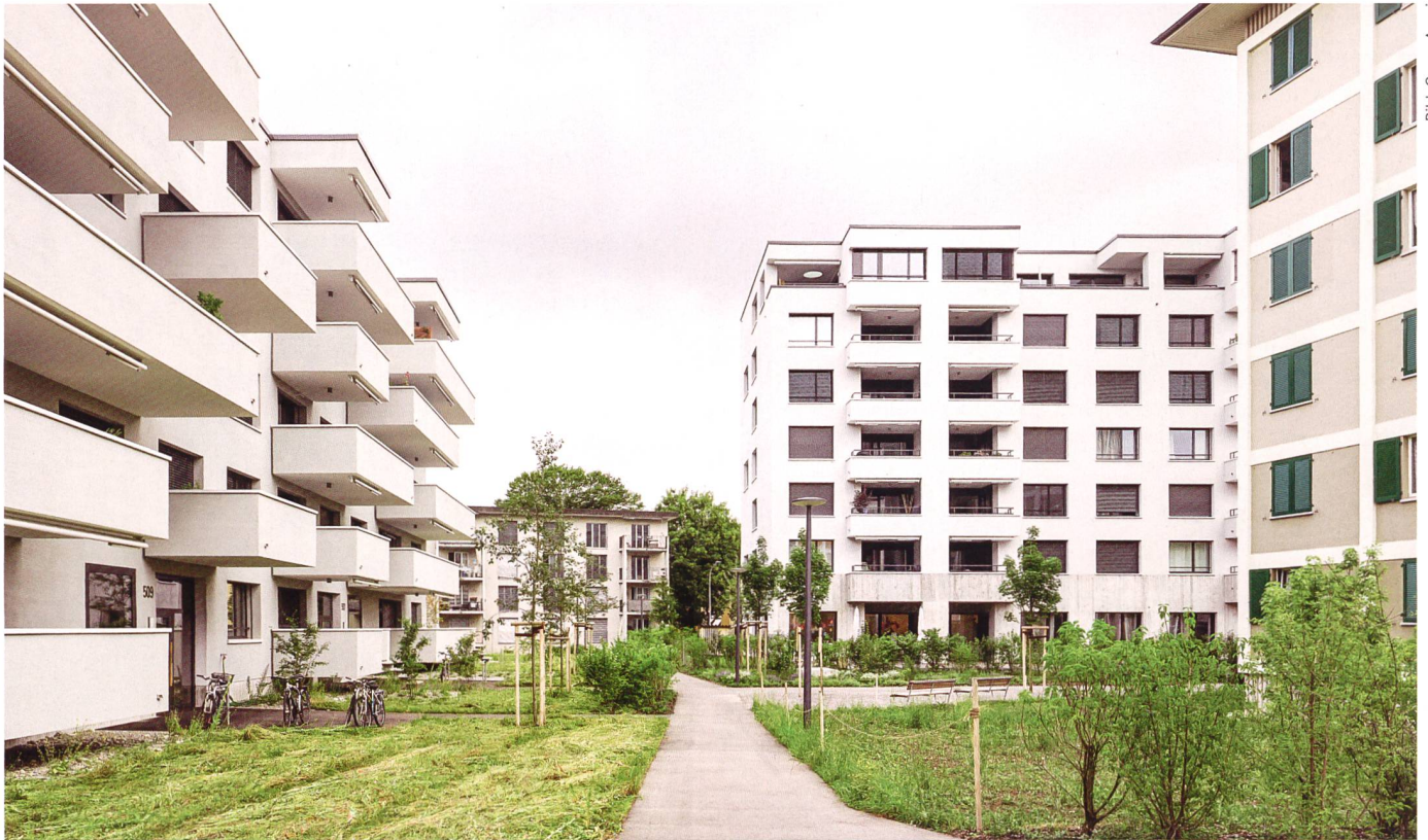
Bild: Georg Aerni
