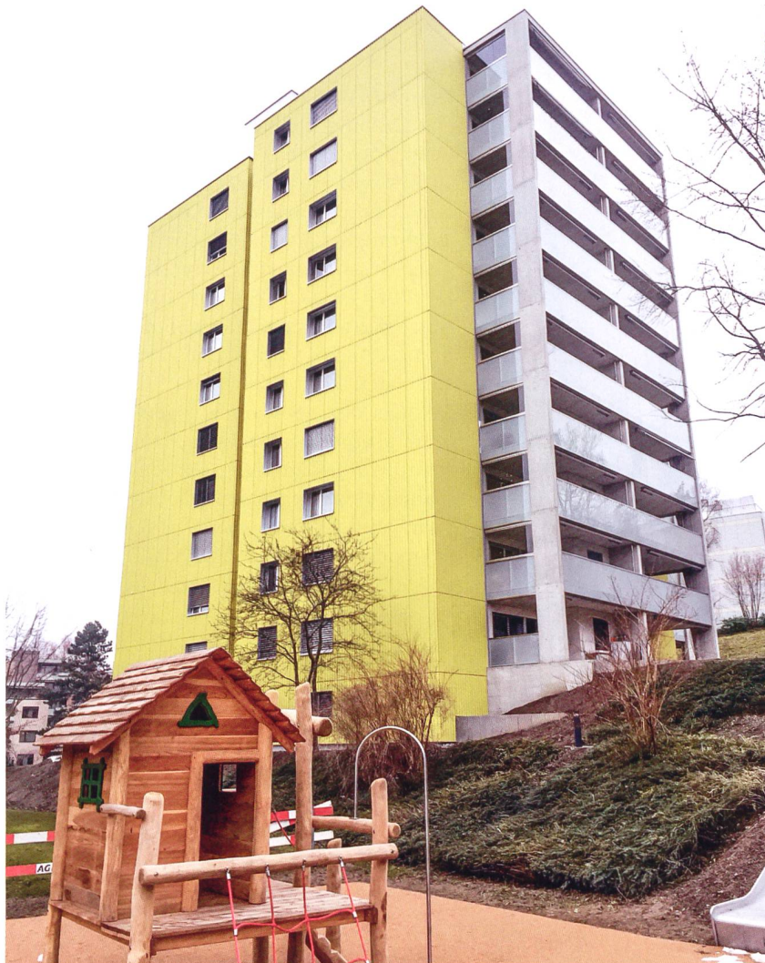
Die GBL wählte gelbe Welleternelemente für die Erneuerung ihres Hochhauses Kleinzelligli in Schlieren (ZH). Links: früherer Zustand mit Gebäudehülle aus Modulbacksteinen.
