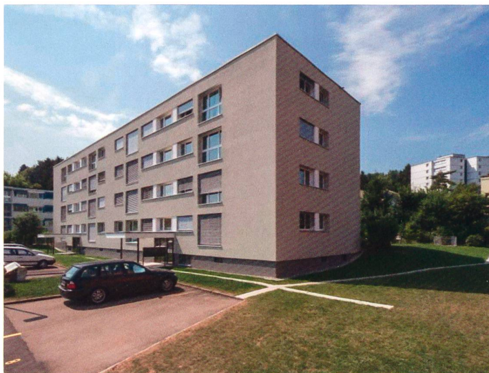
Gesamtsanierung MFH Am Brunnenbächli in Zollikerberg
