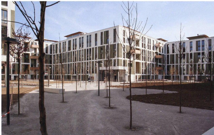
Die Baugenossenschaften GBMZ und Hagenbrünneli teilen sich die Siedlung Klee mit insgesamt 340 Wohnungen.
