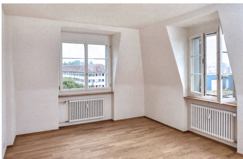
Saniertes Zimmer im Dachgeschoss. Die Böden und die Decken in den Häusern sind neu gedämmt und bieten besseren Schallschutz als früher, allerdings nicht auf Neubausniveau.
