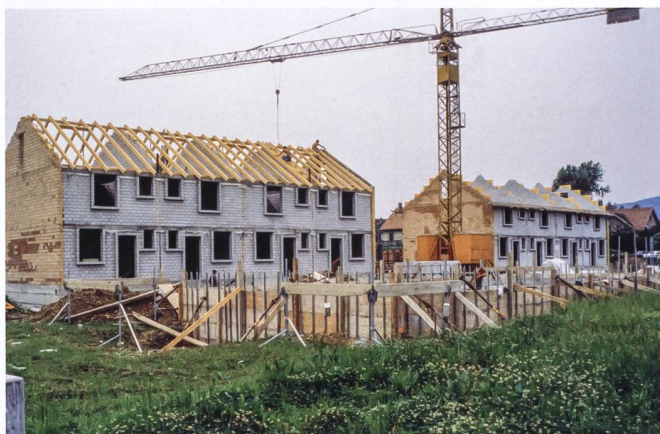
Identische Grundrisse und ein tiefer Ausbaustandard sorgten für einen kostengünstigen Bau. Damit konnten sich auch Arbeiterfamilien die Miete eines Reihenhauses leisten. Oben die Siedlung ganz zu Beginn (undatierte Aufnahme).
