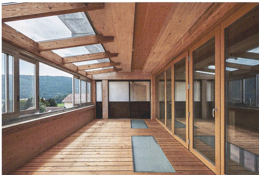
Beim Ökohaushaus in Ste-Croix haben Bewohnerinnen und Bewohner auch selbst Hand angelegt: Sie haben zum Beispiel Lehmsteine hergestellt und Zwischenwände gebaut. Die verglaste Doppelhülle, die als Veranda nutzbar ist, dient der Isolation und passiven Solarnutzung.
