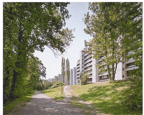
Eines der besprochenen Beispiele: Die Grossüberbauung Telli in Aarau (AG) wurde in bewohntem Zustand energetisch saniert.
