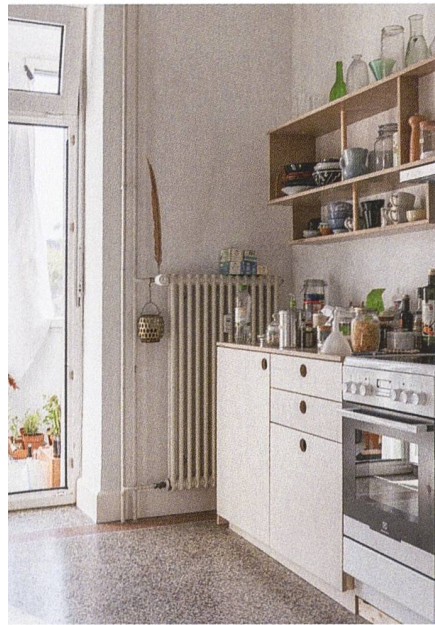
An der Elsässerstrasse 137 waren die Waschbecken in den Küchen noch gut in Schuss. Sie wurden nach der Sanierung wiederverwendet und erhielten neue Untermöbel aus Holz.
