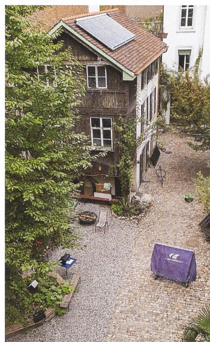
Wenn Bewohnende dies wünschen, können sie sich an Umbauarbeiten beteiligen. An der Mattenstrasse 74/76 beispielsweise haben sie unter Anleitung eines Profis den Innenhof selbst gepflastert.
